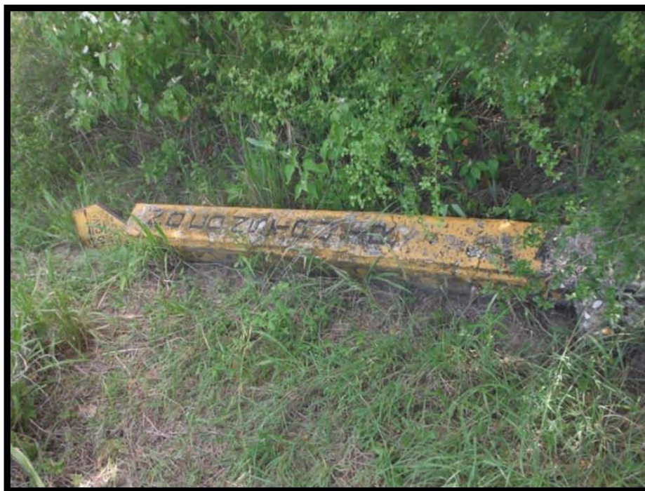
Fotografía 25.- Poste tipo 4 derribado X: 608764 Y: 2490834.
