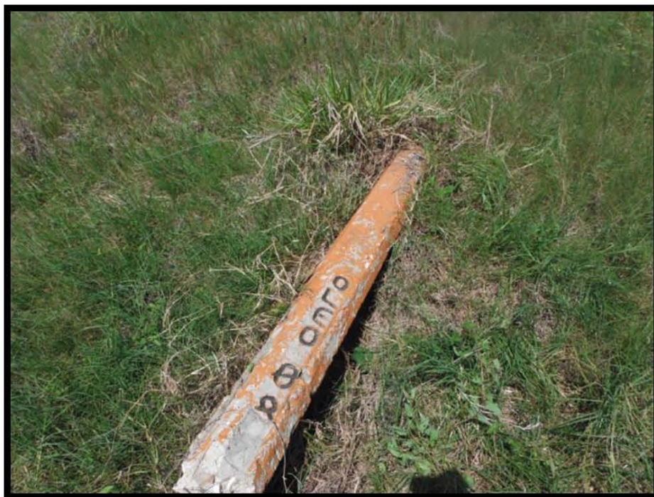
Fotografía 19.- Poste tipo R derribado y sin rotulación del kilometraje X: 608507 Y: 2491416.
