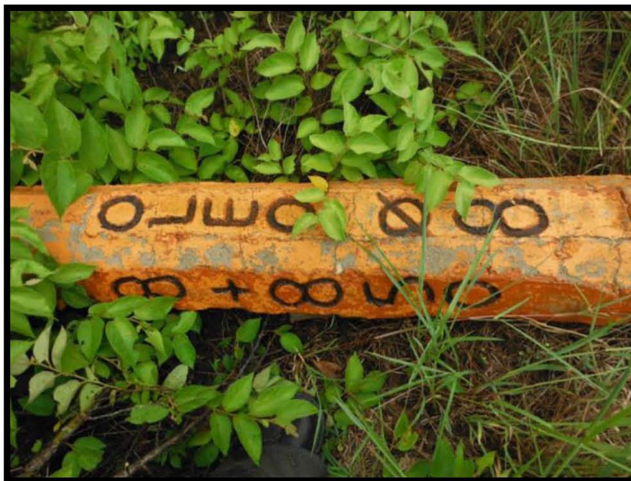
Fotografía 39.- Poste tipo R LDD 8" km 8+850 derribado, X: 609877 Y: 2488253.
