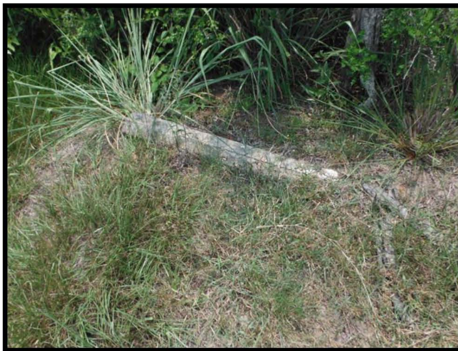
Fotografía 14.- Poste tipo R sin rotulación, derribado X: 607624 Y: 2493731.
