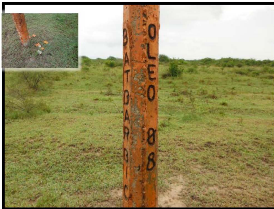
Fotografía 28.- Poste tipo R sin rotulación de kilometraje X: 609338 Y: 2489504.
