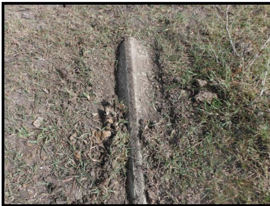
Fotografía 7.- Poste catódico enterrado sobre derecho de vía 10" - 8" X: 606736 Y: 2495519.
