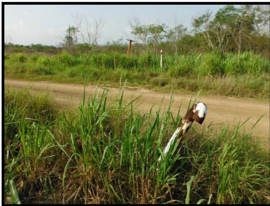
Fotografía 3.- Indicador de cruce con camino de acceso ladeado X: 606076 Y: 2497103.
