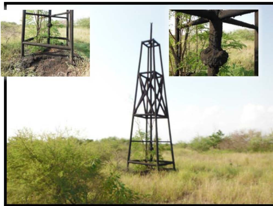
Fotografía 4.- Quemador dentro del derecho de vía del oleoducto de 8", con hidrocarburo intemperizado en su estructura y en la periferia. X: 606091 Y: 2497038.
