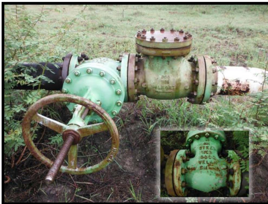
Fotografía 31.- Corrosión en válvula de seccionamiento X: 609377 Y: 2489422.
