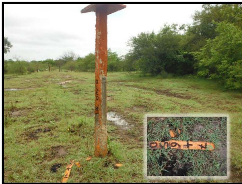
Fotografía 32.- Poste tipo R dañado, Km 7+650, X: 609427 Y: 2489290.
