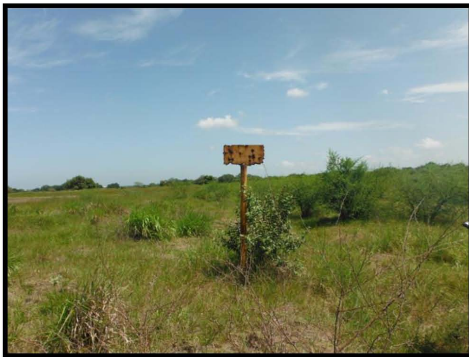
Fotografía 20.- Señalamiento tipo 4 con corrosión y sin rotulación X: 608570 Y: 2491279.
