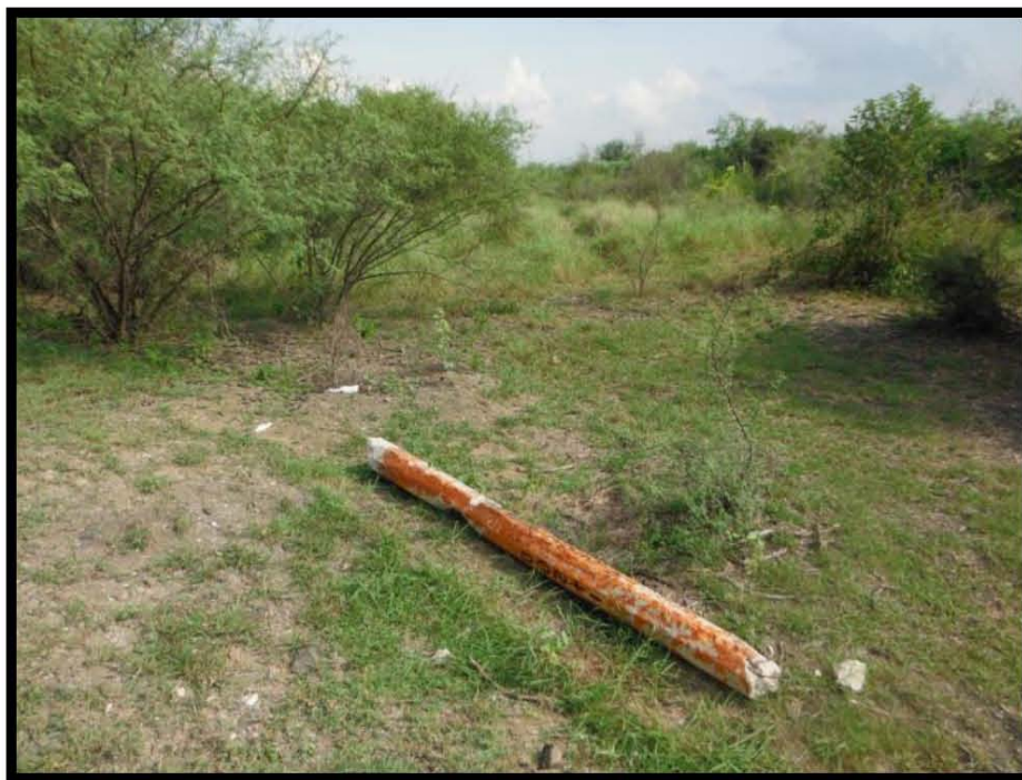
Fotografía 5.- Poste tipo R KM 1 + 200 LDD 8" derribado X: 606486 Y: 2496693.
