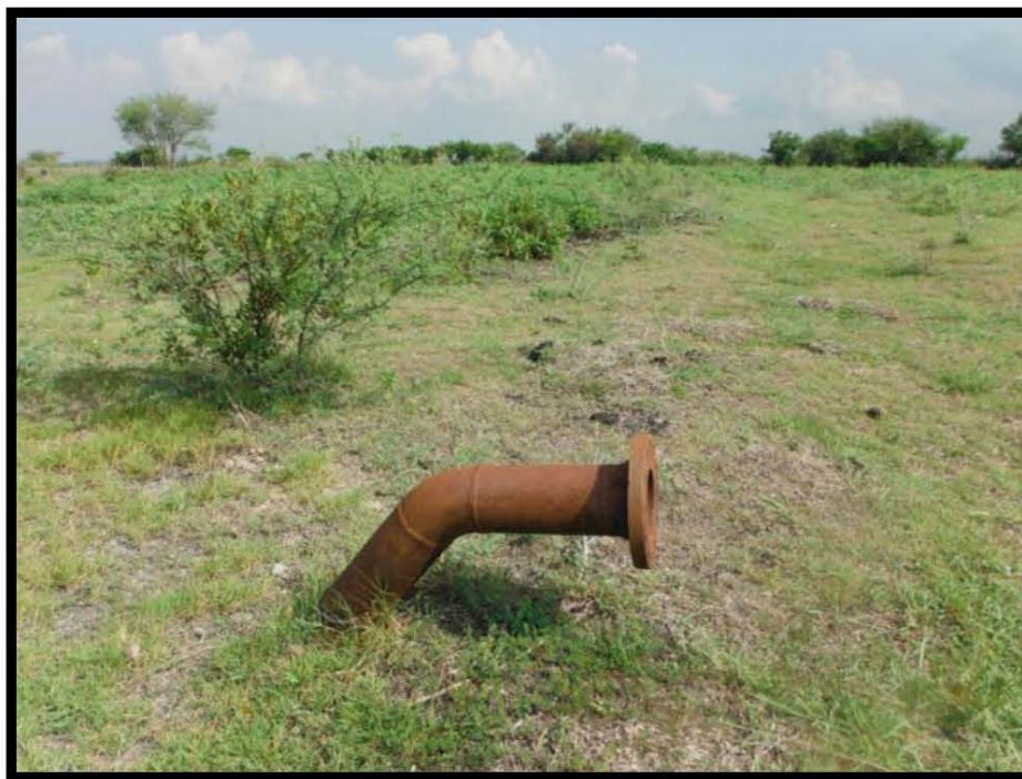
Fotografía 6.- Tubería expuesta sobre derecho de vía del Oleoducto de 8"X: 606660 Y: 2495682.
