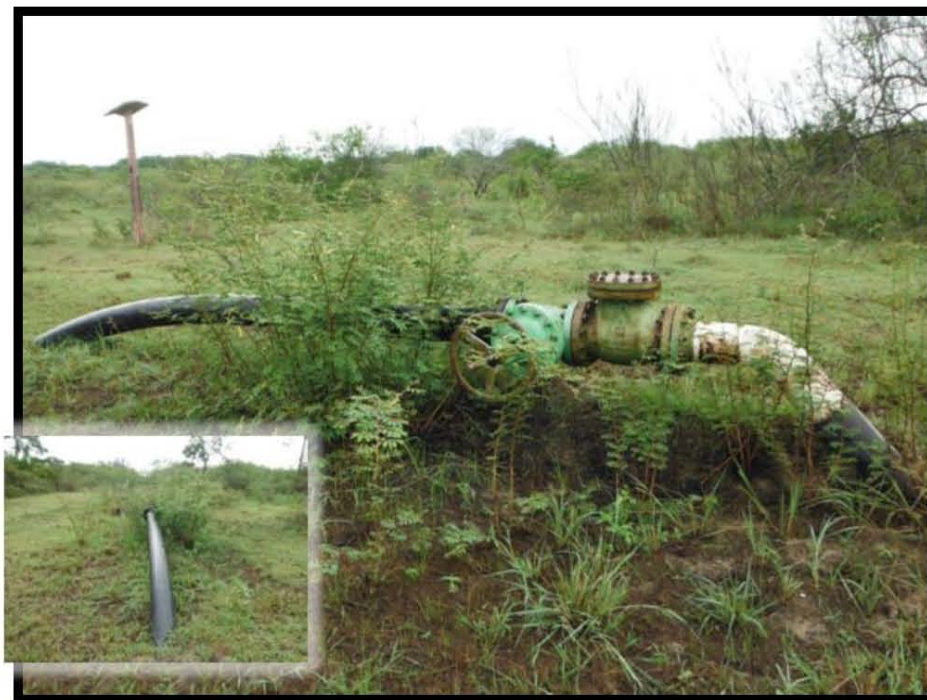
Fotografía 30.- Válvula de seccionamiento sin rotulación X: 609377 Y: 2489422.
