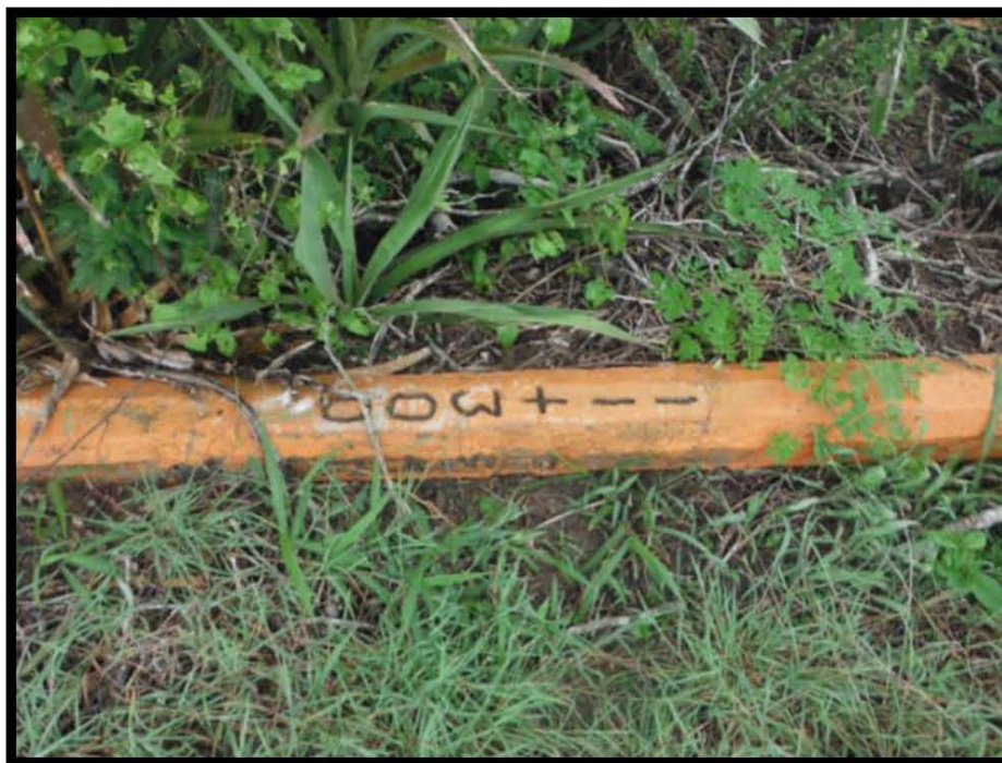
Fotografía 45.- Poste tipo R LDD 8" km 11+300 derribado, X: 610737 Y: 2486281.
